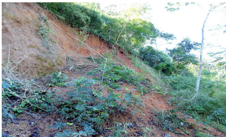
Figura 1: Vista do processo erosivo em encosta da serra, desestabilizada pela construção da estrada. O material desagregado está sendo carreado para o
