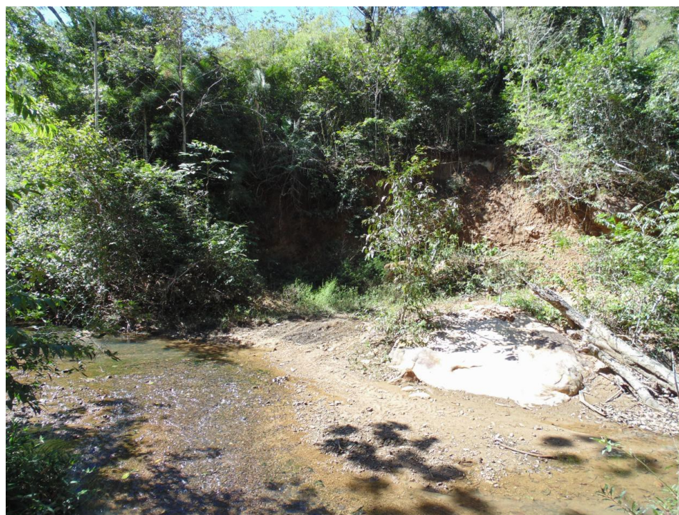
Figura 3: Processo erosivo originado pela implantação da estrada, ocasionando desmoronamento de parte da encosta localizada dentro da APP do Córrego Sucuri, cujo material desagregado está sendo carregado diretamente ao leito do curso d'água.
