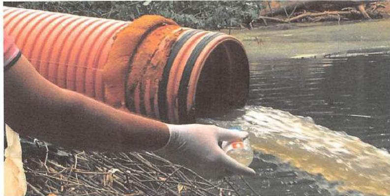
Imagem 9 – Efluente tratado – Coleta na saída do emissário devido a ausência de caixa de inspeção / amostragem.
