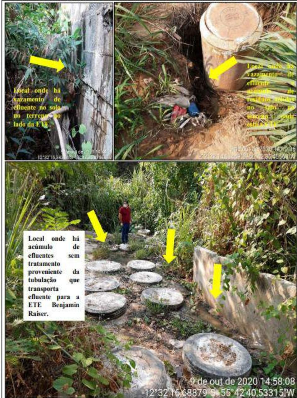
Nas imediações da ETE Mario Raiter constatou-se estruturas danificadas e que foram operacionalizadas de maneira adaptada (Figura 05). Essa adaptação propicia a liberação de gases de odor fétido, que afetam os moradores das proximidades bem como incorre na contaminação do solo.
