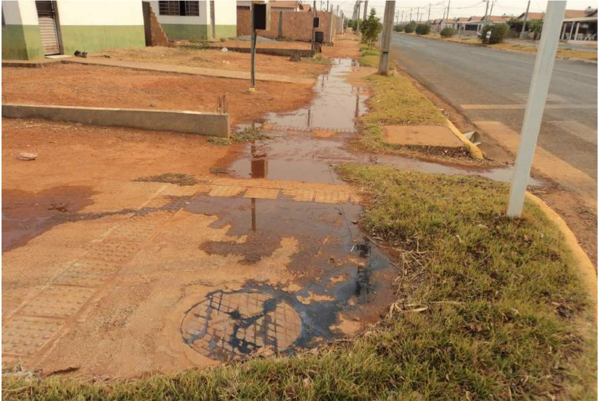
**(vazamento de esgoto de poço de visita no Bairro Mário Raiter)**
