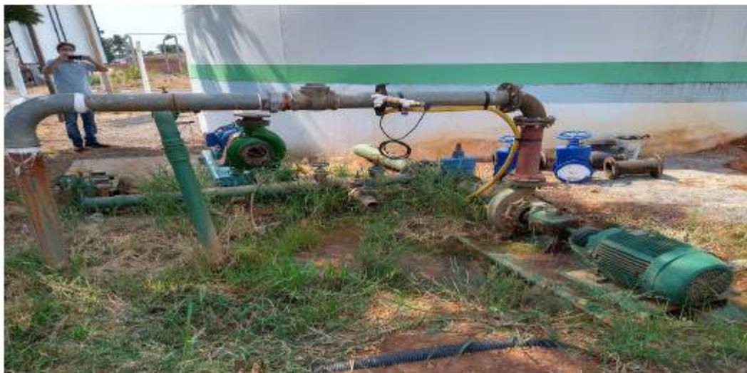
2) A tubulação da bomba estava com ferrugem e remendada de forma improvisada com fita veda rosca:
