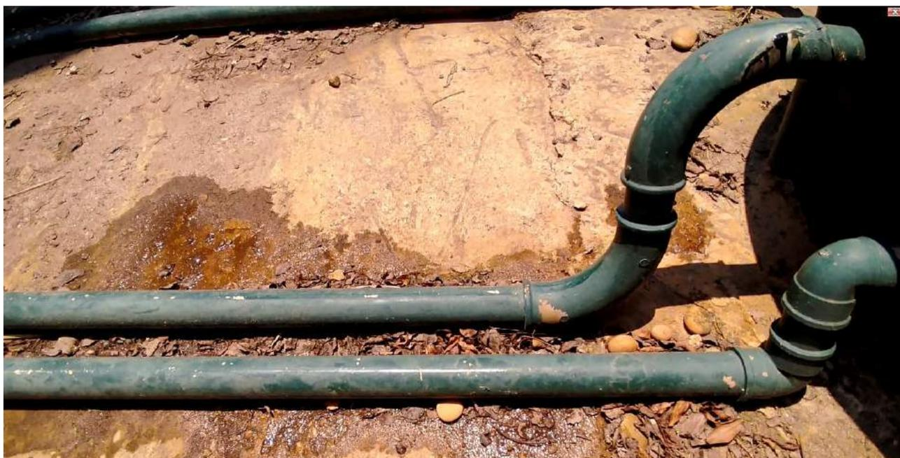
(equipamentos danificados provocando transbordamento dos efluentes e mau cheiro frequente na estação Pinheiros III – visita inspeccional realizada por este Agente Ministerial no dia 9/10/2020):
