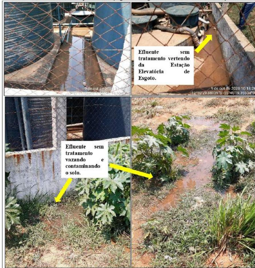
Nas imediações da ETE Pinheiros III constatou-se manutenção precária do sistema. As tubulações que interligam os compartimentos do ETE compacta, estavam quebrados. O isolamento da ETE é feito de modo precário (com madeiras e telas) não impedindo o acesso de pessoas ou animais aos compartimentos do sistema (Figura 02).
