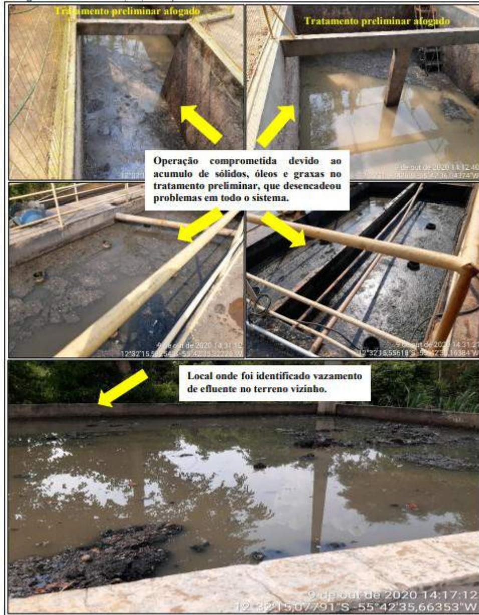
**Figura 04:** Imediações da Estação de Tratamento de Efluente (ETE) Benjamin Raiser: Constatou-se locais onde há lançamento de efluentes no solo (registros fotográficos feitos em 09/10/2020).
