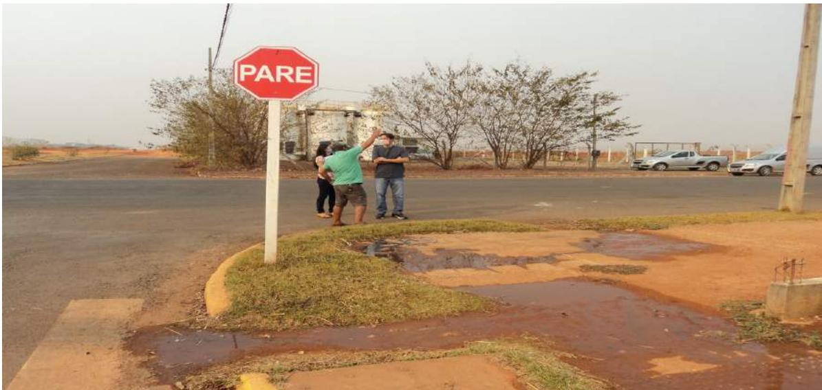
**(vazamento de esgoto de poço de visita na frente da referida estação de tratamento)**
