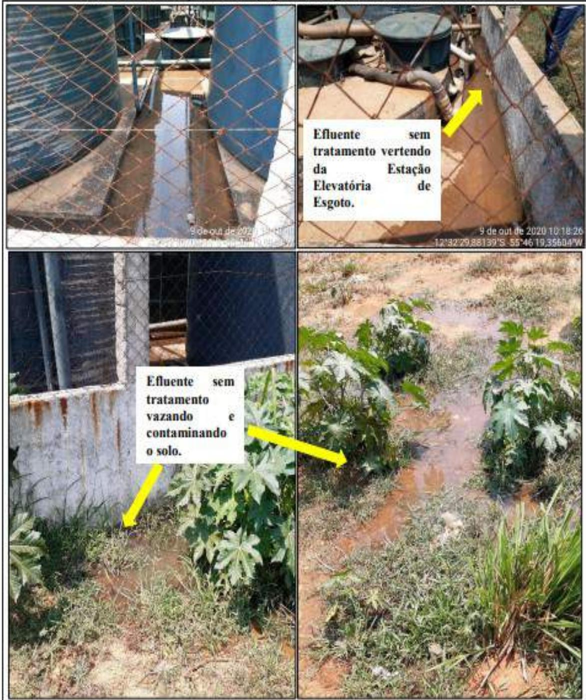
**Figura 03:** Irregularidades constatadas na Estação de Tratamento de Efluente (ETE) Benjamin Raiser: todas as etapas do tratamento foram comprometidas pelo mau funcionamento do tratamento preliminar; contaminação do solo no terreno ao lado e na própria dependência da ETE (registros fotográficos feitos em 09/10/2020).
