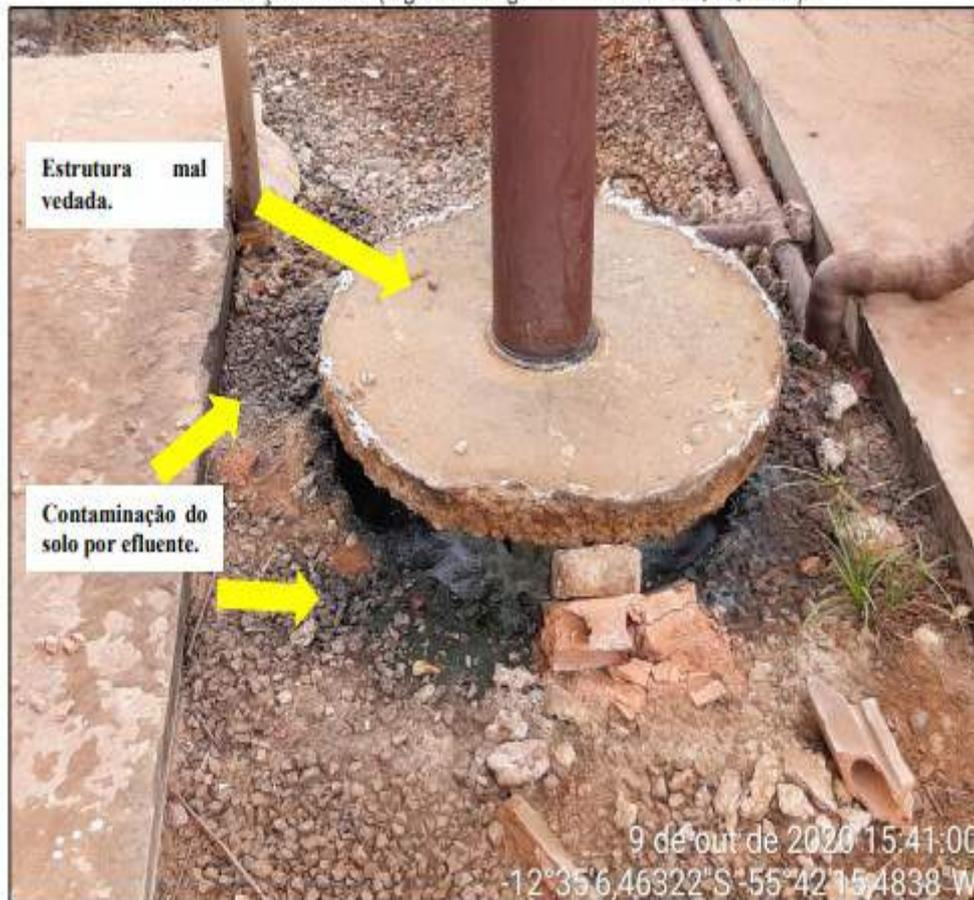
Nas imediações da ETE São Francisco constatou-se estruturas danificadas e sem manutenção adequada (Figura 06). A ausência de manutenção adequada propicia a liberação de gases de odor fétido, que afetam os moradores das proximidades e geram problemas que representam risco aos operadores.
